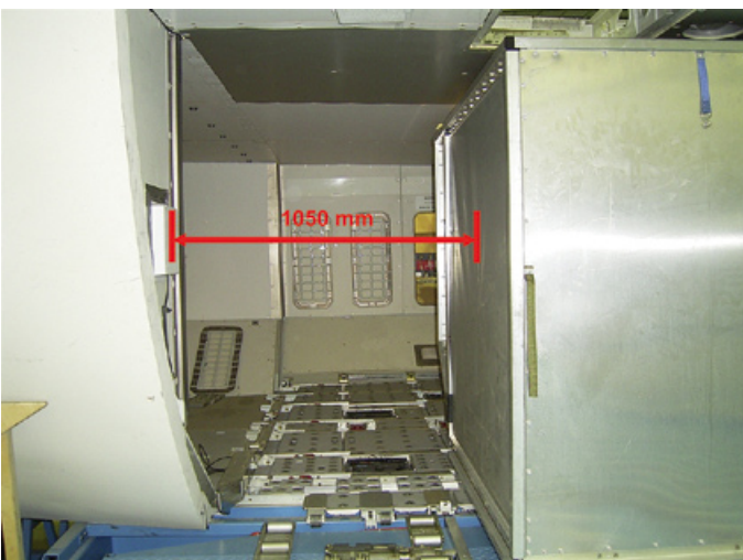
Bei dieser Installation ist die Entfernung zwischen Antenne und Dokumententasche maximal.
